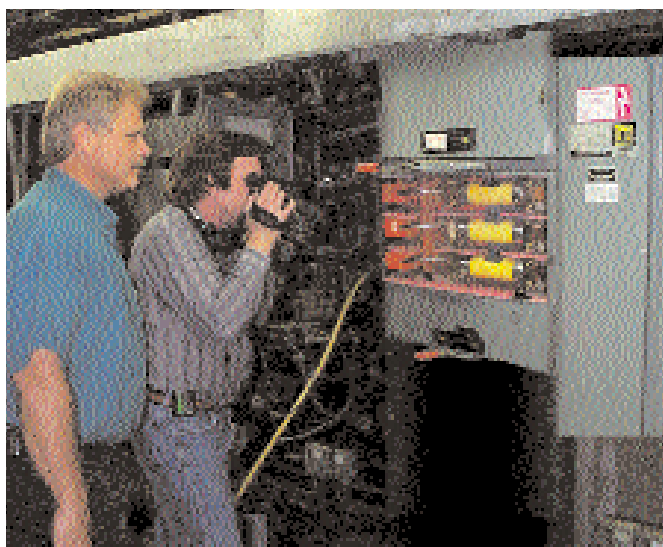
Scannen eines Sicherungspanels mit einer ThermaCAM
