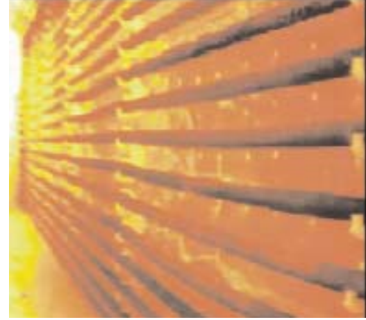
Helle Stellen auf der Infrarotaufnahme bezeichnen Zonen mit Kohlenstoffablagerungen in Prozessofenröhren.
